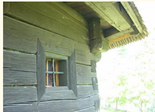
Detail zrubovej konštrukcie utesnenej machom
